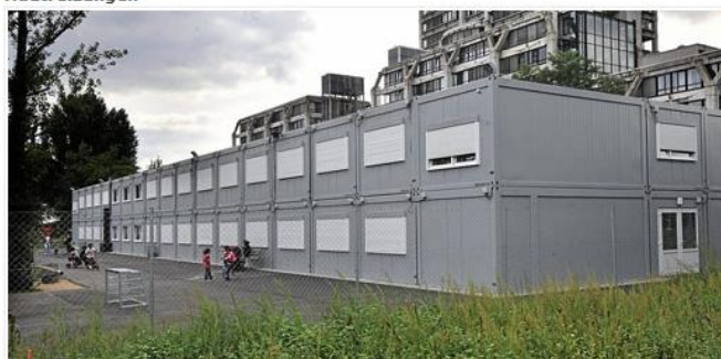
In diesen Containern sind die 270 Kinder der Hellerhofschule untergebracht. Zwei Jahre soll das Provisorium Bestand haben. Foto: Martin Weis
