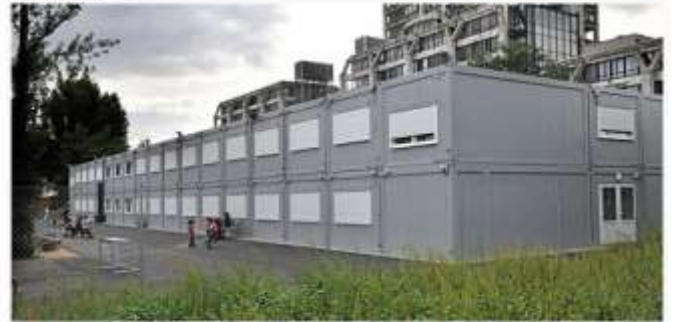
In diesen Containern sind die 270 Kinder der Hellerhofschule untergebracht. Zwei Jahre soll das Provisorium Bestand haben. Foto: Martin Weis
