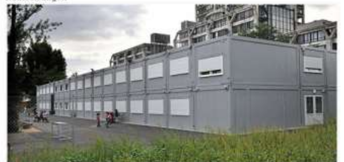
In diesen Containern sind die 270 Kinder der Hellerhofschule untergebracht. Zwei Jahre soll das Provisorium Bestand haben. Foto: Martin Weiss
