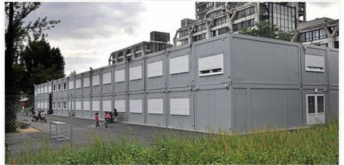
In diesen Containern sind die 270 Kinder der Hellerhofschule untergebracht. Zwei Jahre soll das Provisorium Bestand haben. Foto: Martin Weis
